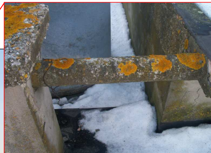
Parapetto tubolare in cemento-amianto
