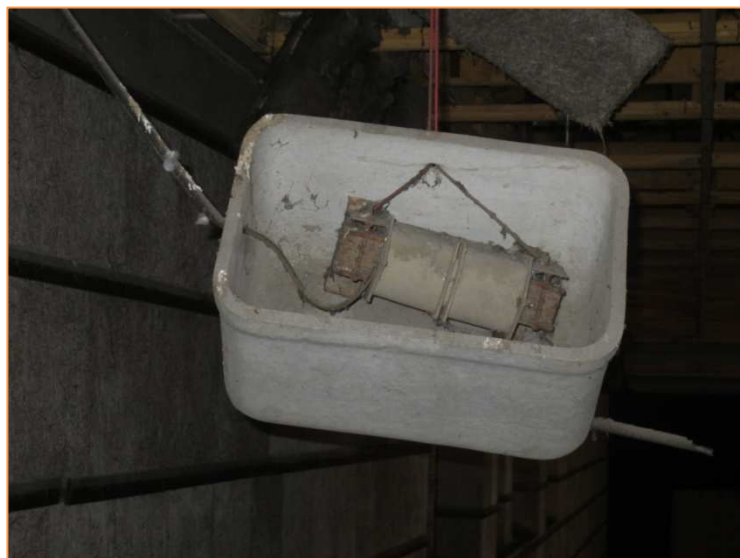
Scatole per impianti elettrici in cemento-amianto
