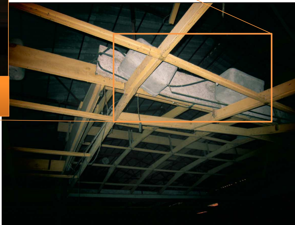
Scatole per impianti elettrici in cemento-amianto
